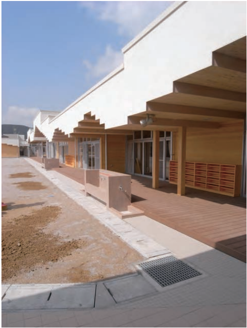
保育室デッキテラス
